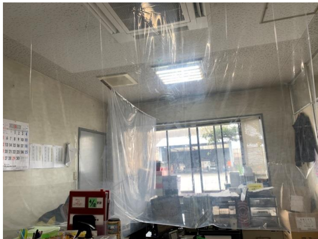
点呼室のビニールカーテン
